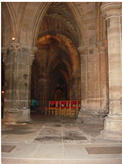
图 1： St. Mungo 教堂地下层
