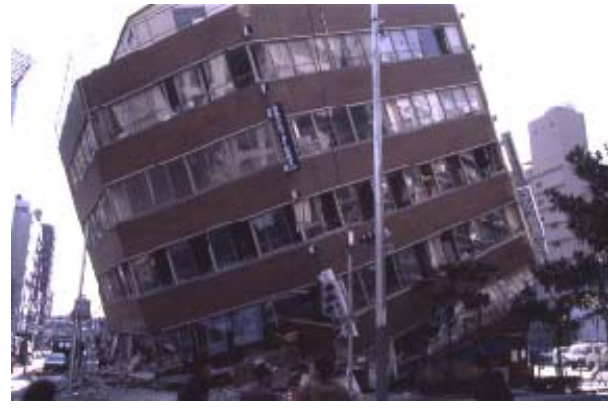
阪神淡路大地震中倒塌的建筑物
