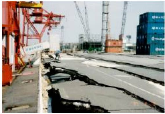
阪神淡路大地震时堤岸发生侧向流动
