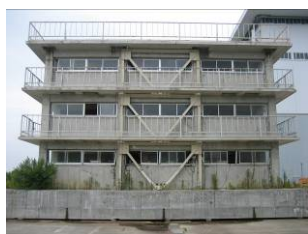
图 1 3 层钢筋混凝土教学楼的附加 V 型钢支撑加固 [4]
