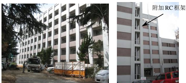
图 9 神戸大学某教学楼利用附加钢筋混凝土框架加固实例
