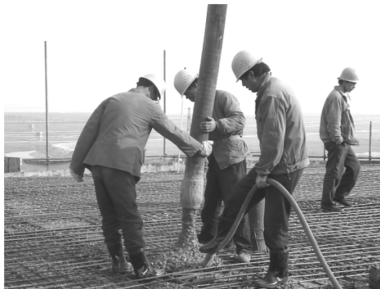
图 4：现场浇筑混凝土
